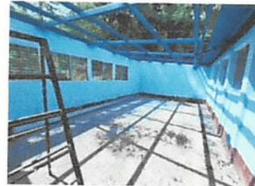
Foto 6: sustitución de canales de agua
