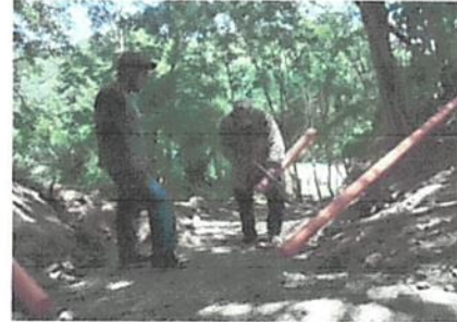
Foto 8: reparación de drenajes de aguas negras
