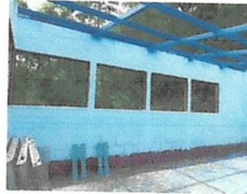
Foto 2: suministro e instalación de ventanas
