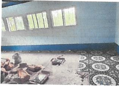
Foto 3: sustitución de piso de torta por piso ceramico
