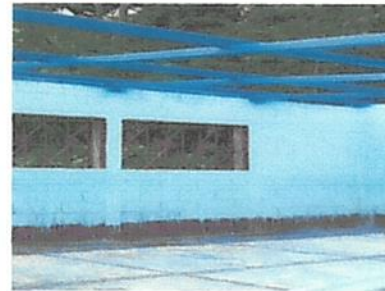
Foto 10: pintura a la estructura del techo
