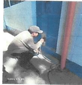
Foto 4: mantenimiento de puerta
